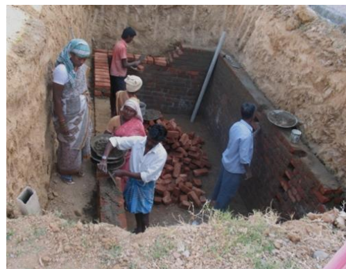
aanleg septic tank
