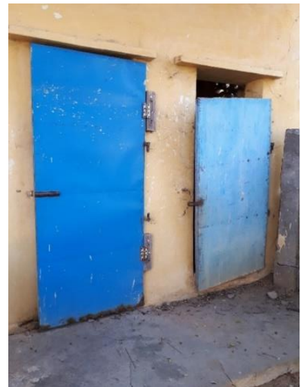
Deuren van bestaande toiletten. Zoals u ziet zijn deze stalen deuren in zeer slechte staat, ook hang en sluitwerk functioneert niet goed meer
