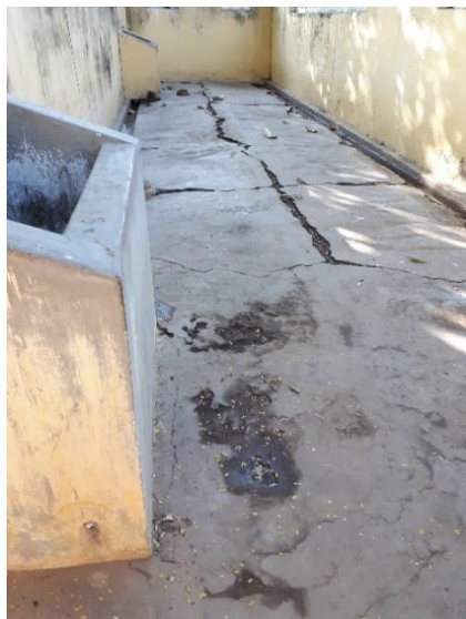
Vloer bestaande toilet
