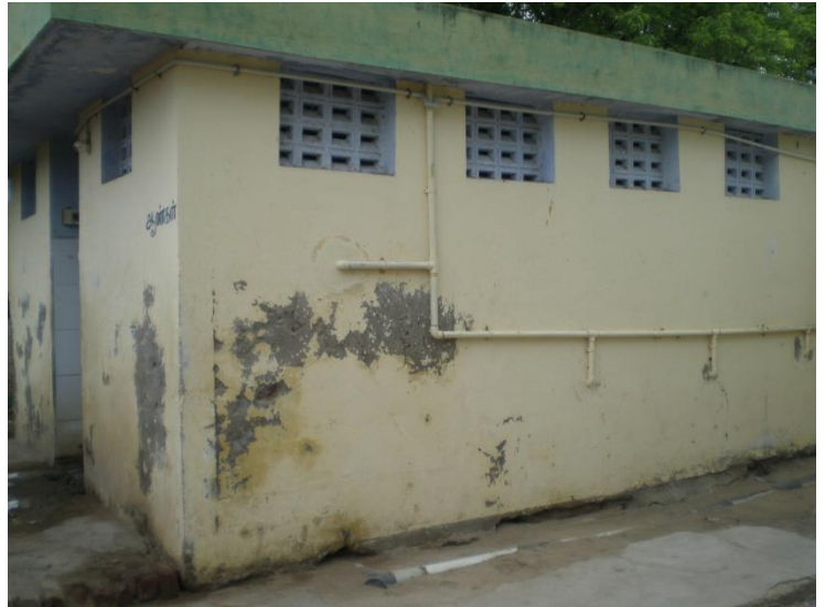
Bestaande toilet gebouw
