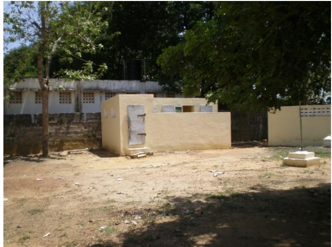
Voor dit oude toilet komt het nieuwe toiletgebouw
