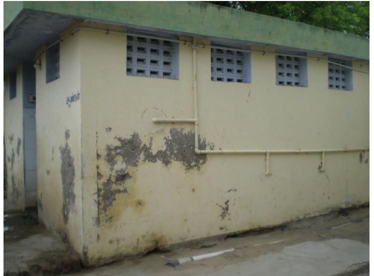
Bestaand toilet gebouw
