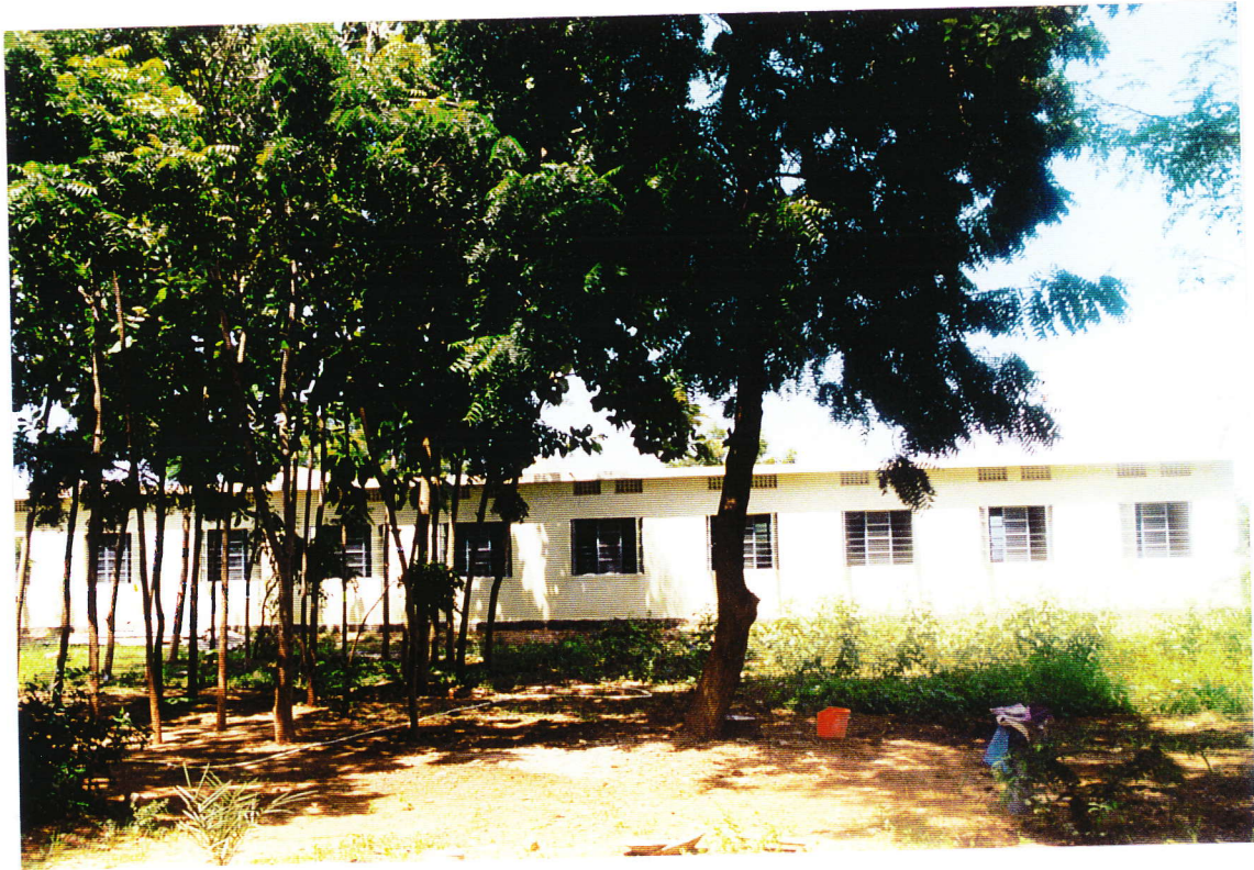
foto 5. Het gerenoveerde schoolgebouw - Achtergevel.
