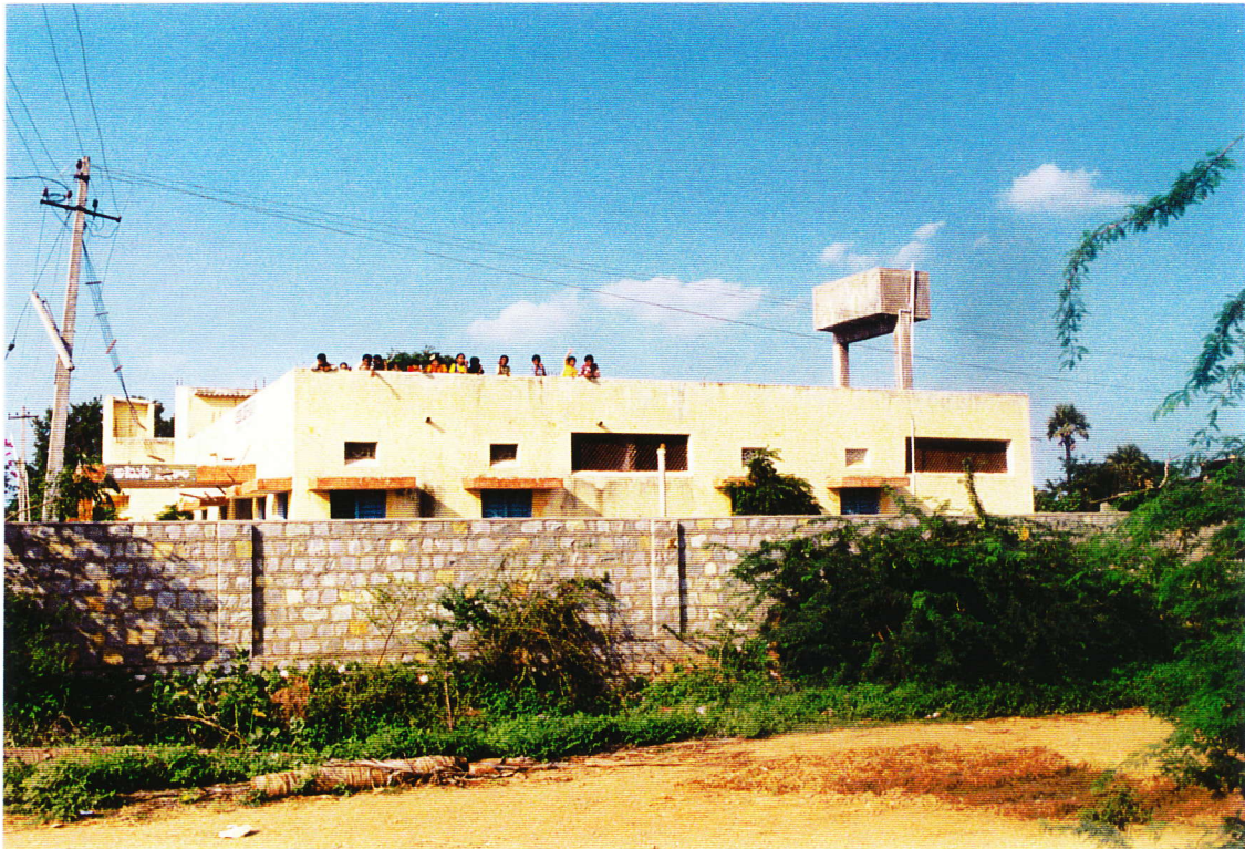
foto 1. Damaracheralá – Omringende muur.
