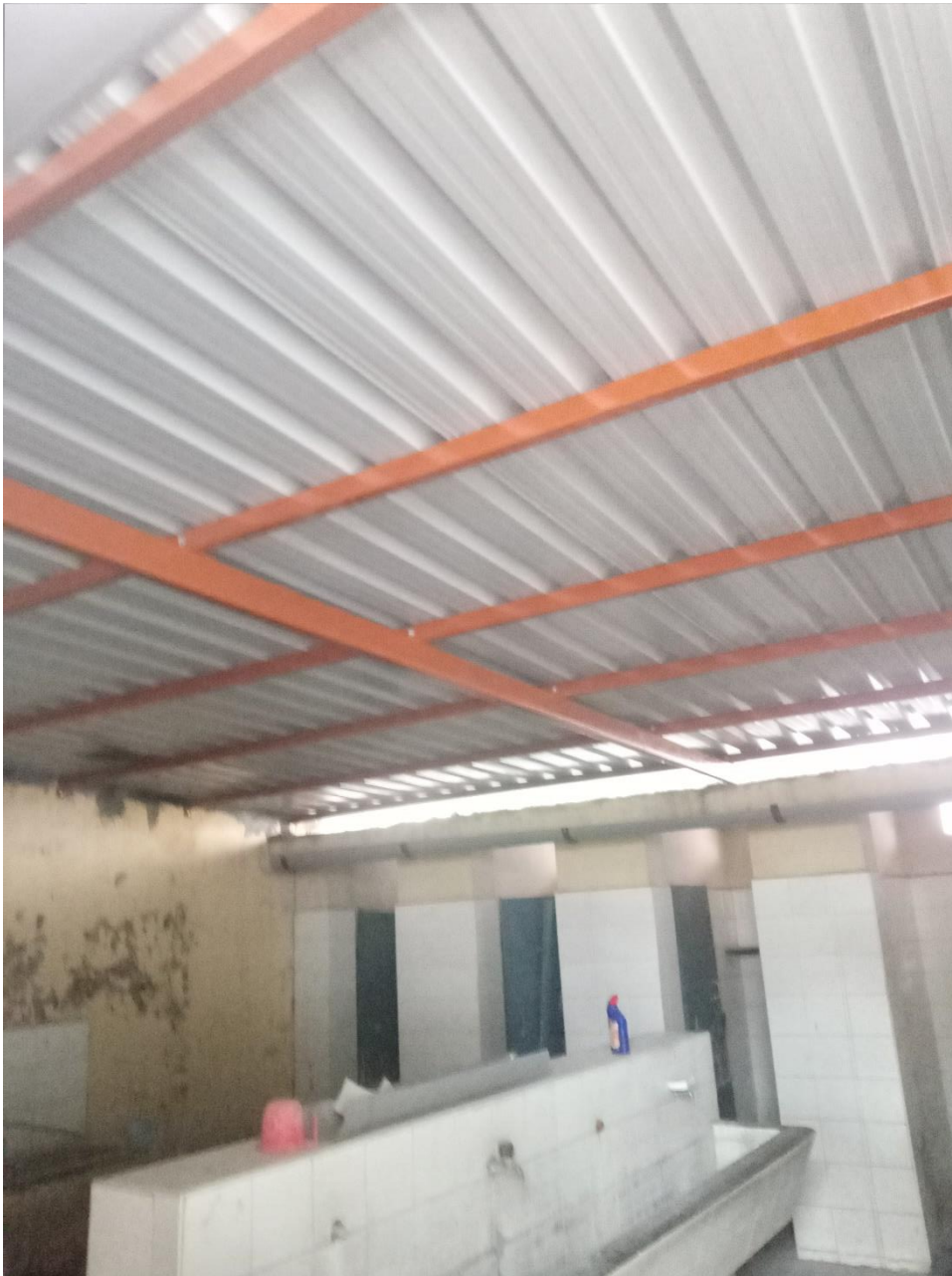
Nieuw dak op toilet
