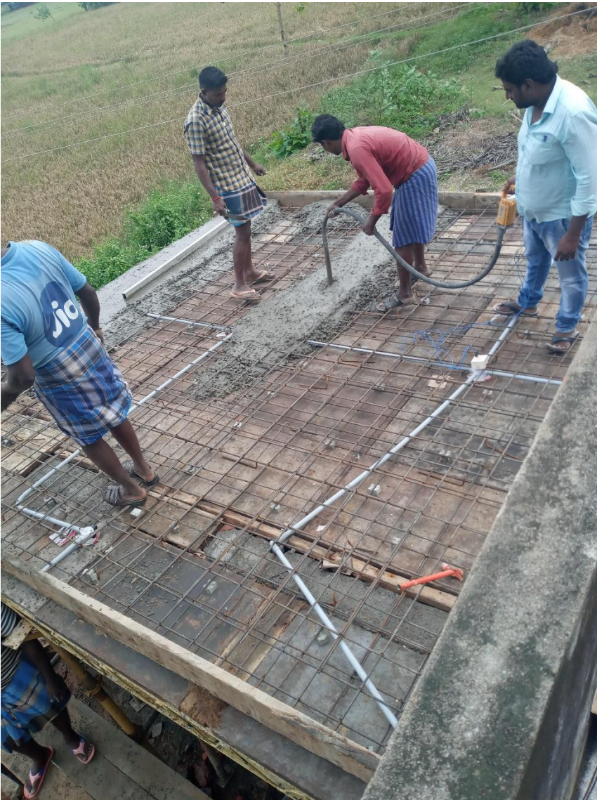
Storten van het dak, december 2020
