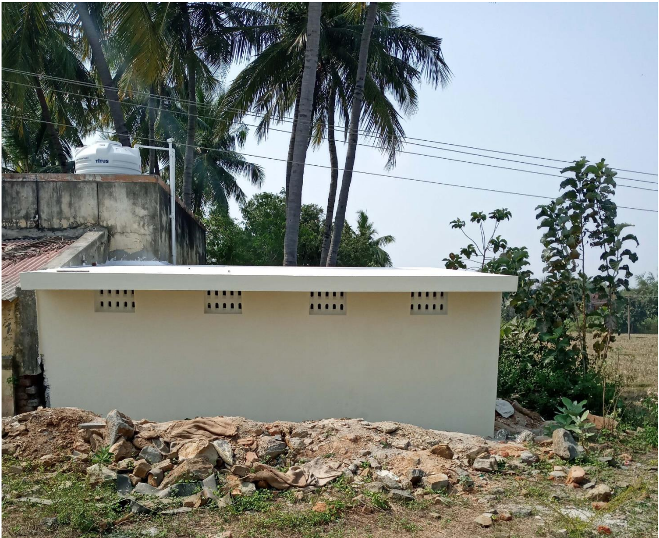
Bouw gereed, 30 januari 2021
