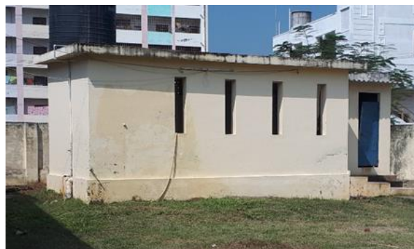
Het huidige toiletblok voor meisjes en leraren
