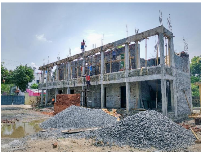
Bouw van de High School
