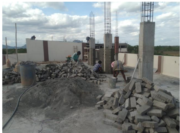
Werkzaamheden aan de nieuwe verdieping
