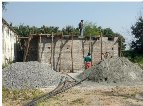
Toiletgebouw in aanbouw
