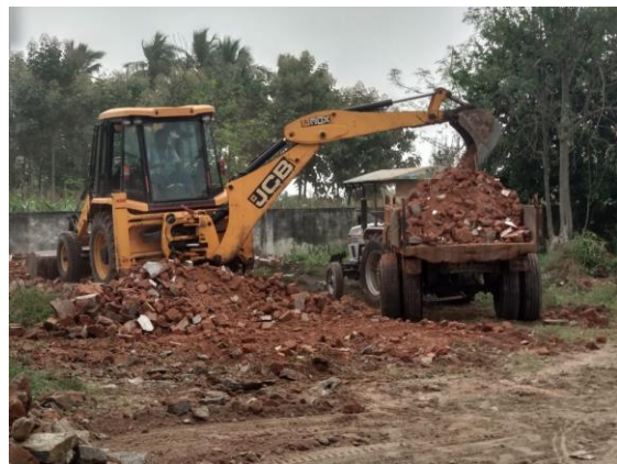
Grondwerk nieuw toiletgebouw
