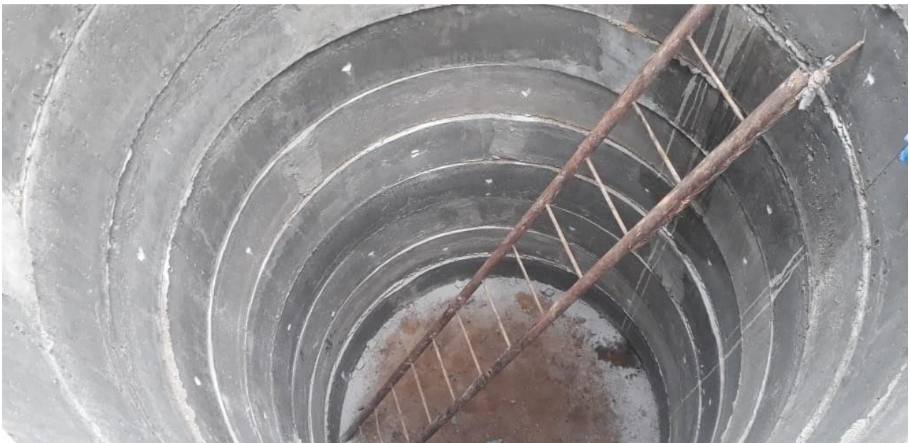
Zakput van binnen met in de wanden duidelijk zichtbaar de gaten voor de waterafvoer
