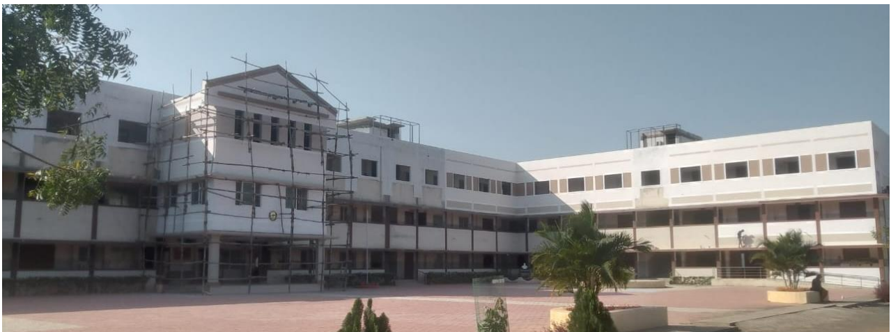
De buitenkant is klaar, er wordt nog gewerkt aan de afwerking
