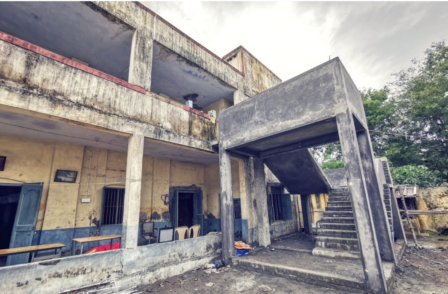
De nieuwe trap aan het oude gebouw
