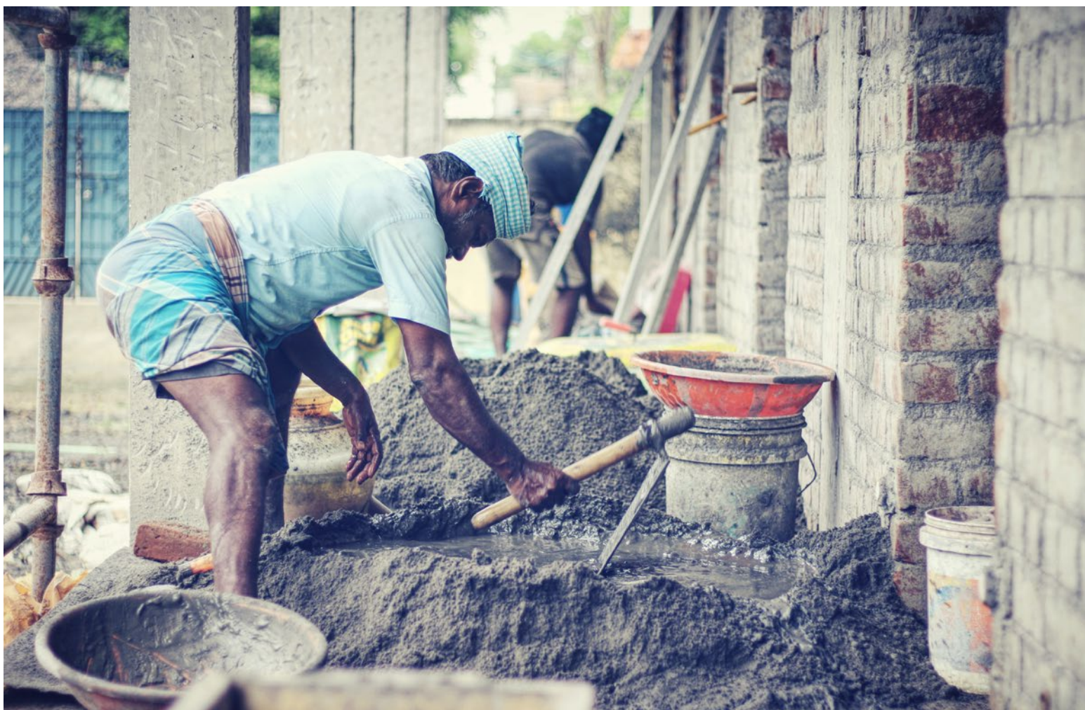
Een medewerker aan de slag voor het nieuwe gebouw
