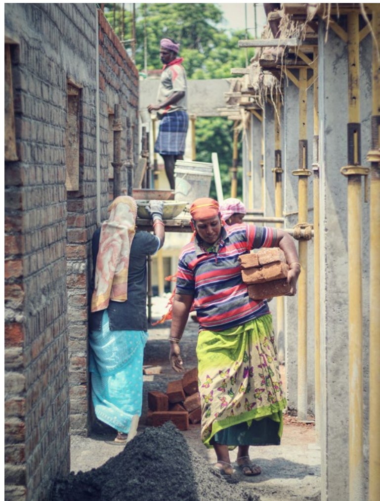
Het versjouden van stenen op de bouw
