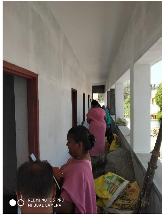
Walajabad inspectie van de bouw High School
