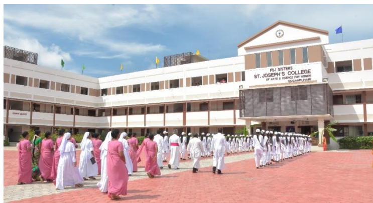
Het nu uitgebreide Singampunari College gebouw met 3 verdiepingen
