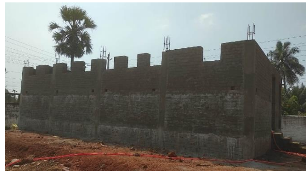
Toiletgebouw Vegiwada in aanbouw
