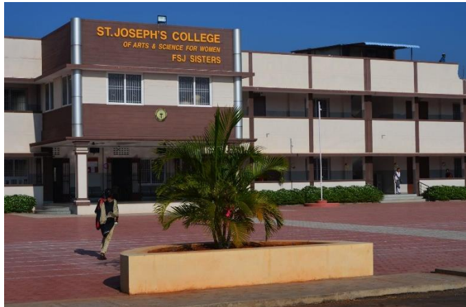
Het oorspronkelijke College gebouw met 2 verdiepingen
