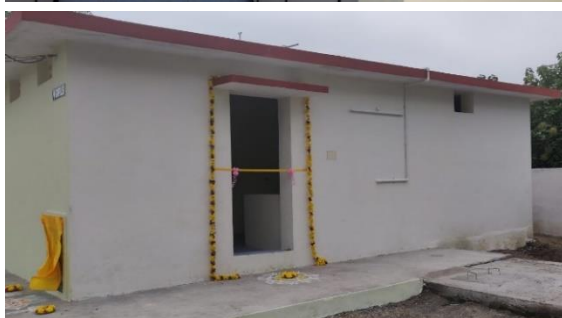
Inzegening nieuw toiletgebouw Thiruvallur
