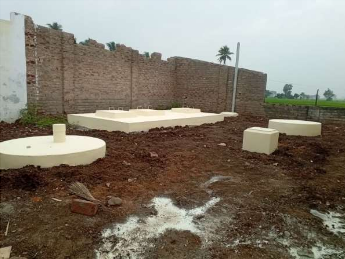
Oktober 2021: soakpit en septic tank
