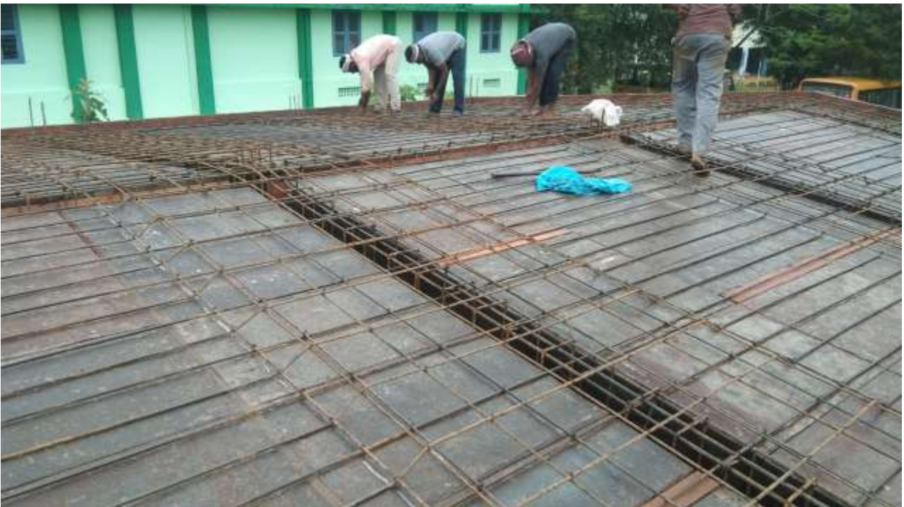
September 2021: Vlechtwerk beton
