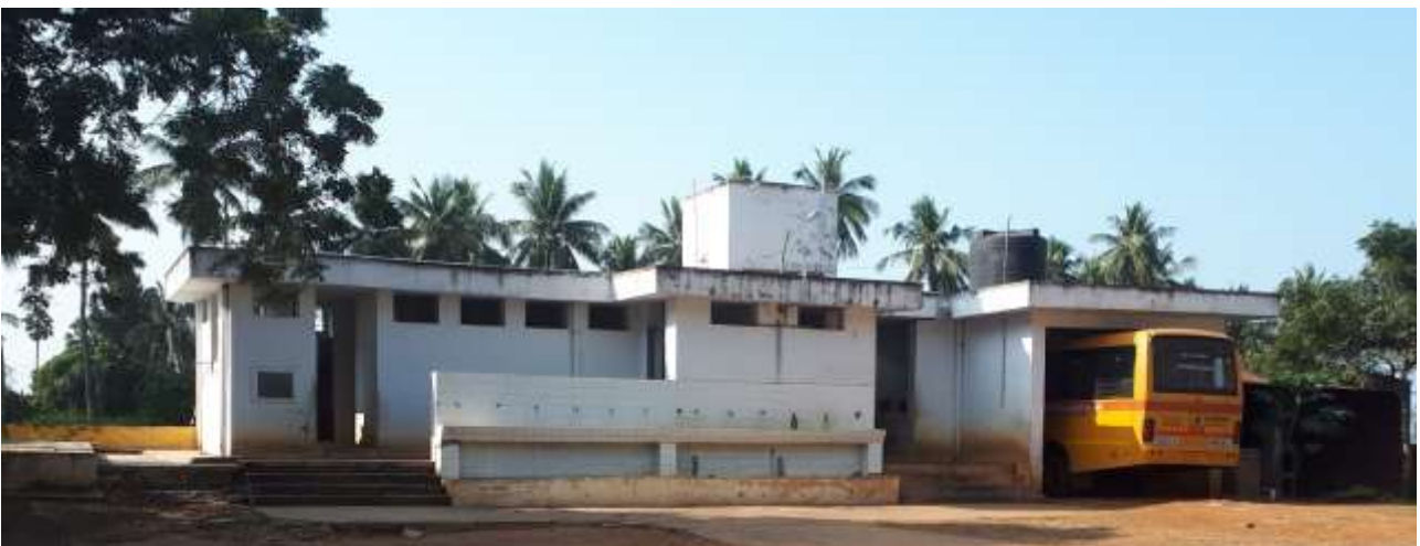
Het oude toiletgebouw waarnaast het nieuwe zal worden neergezet
