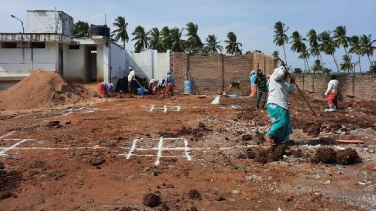
Augustus 2021: Bouwterrein en locatie nieuwbouw
