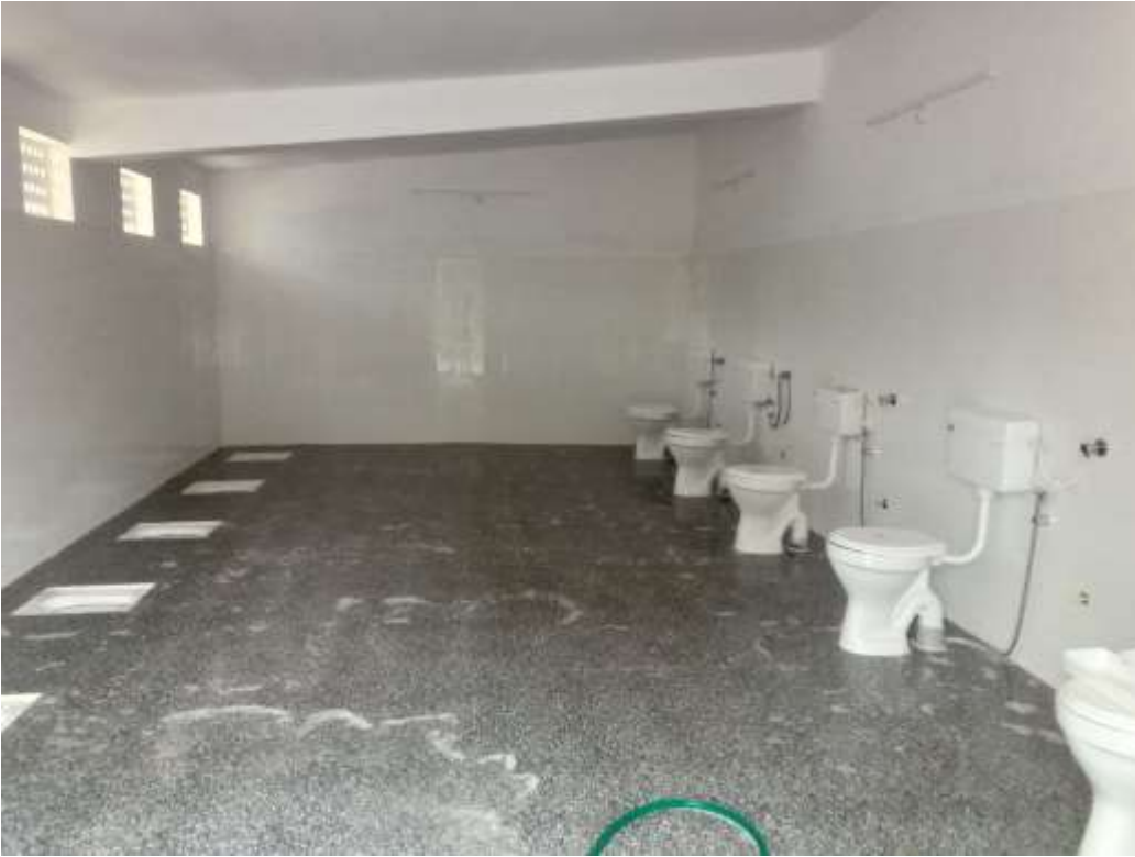
Oktober 2021: Toiletten geplaatst
