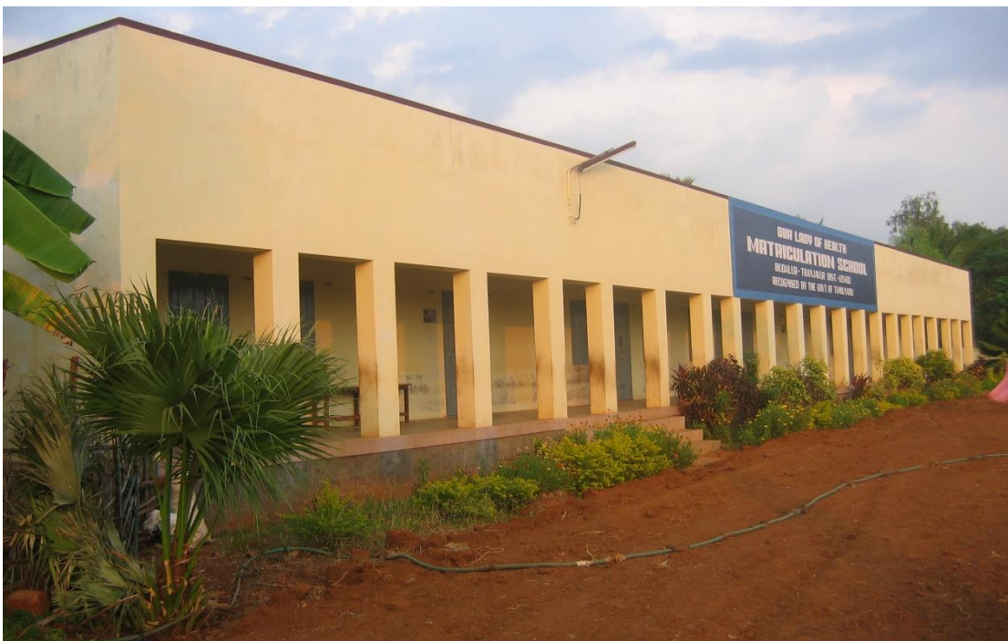
En na renovatie
