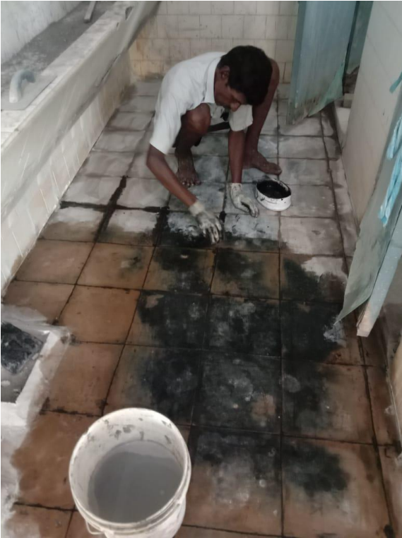
Waterdicht maken vloer wasruimte.
