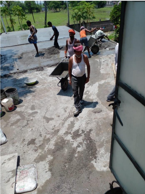
Dak repareren en waterdicht maken
