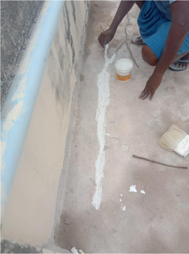
Scheuren in het dak dichten
