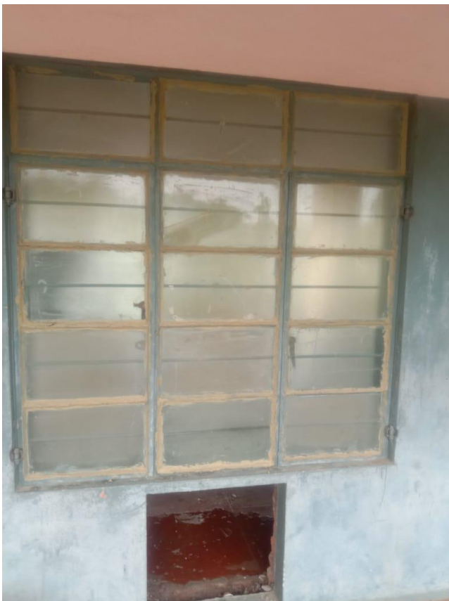
Ruiten en ramen repareren.
