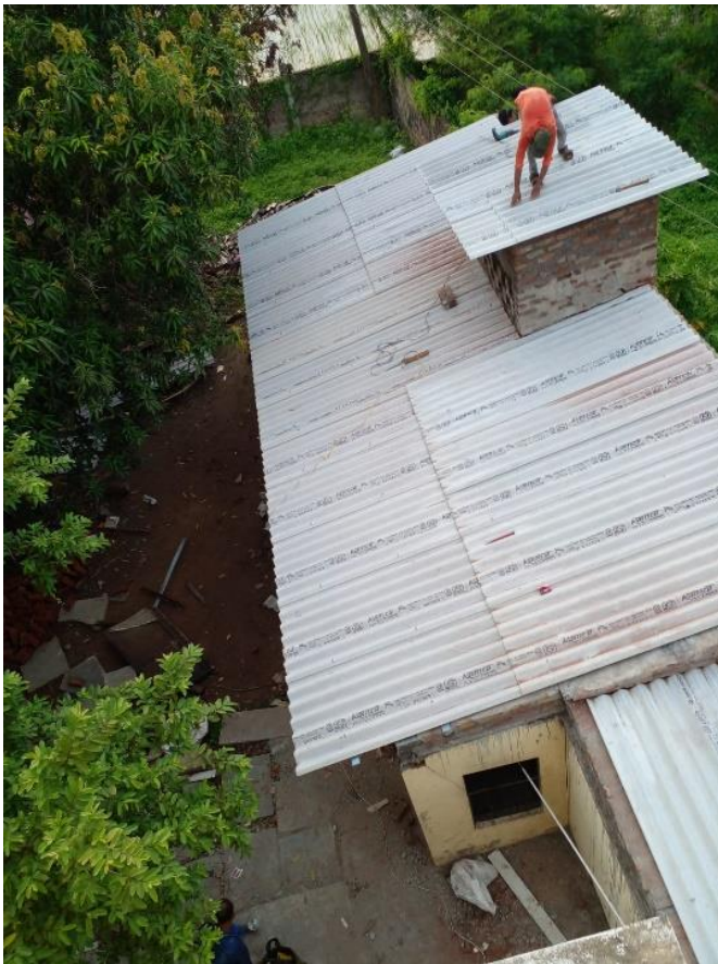
Nieuw dak buitenkeuken.
