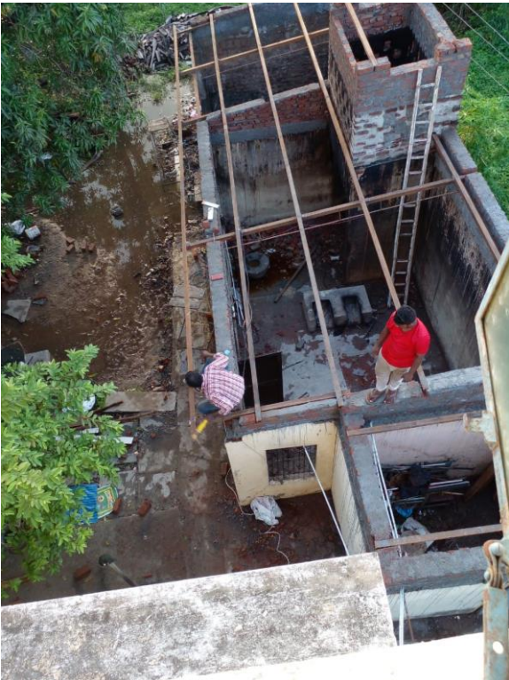
Dak van de buitenkeuken vervangen
