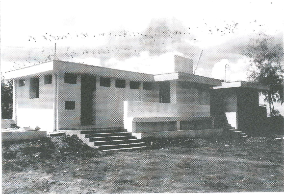
P.T. Parru: toiletgebouw voor schoolkinderen
