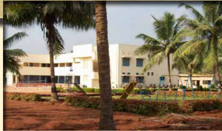
2006 VEGIWADA. Schoolgebouw met 6 klaslokalen en algemene ruimten. Alles op de begane grond. 2008. Verdieping op deze school met 8 klaslokalen. Totaal nu 14 klaslokalen.
