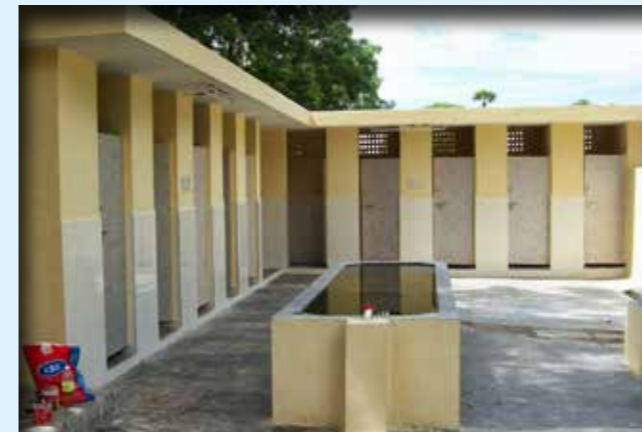
2013. KAMALAPURAM Uitbreiding toiletten en badruimten voor de boarding.
