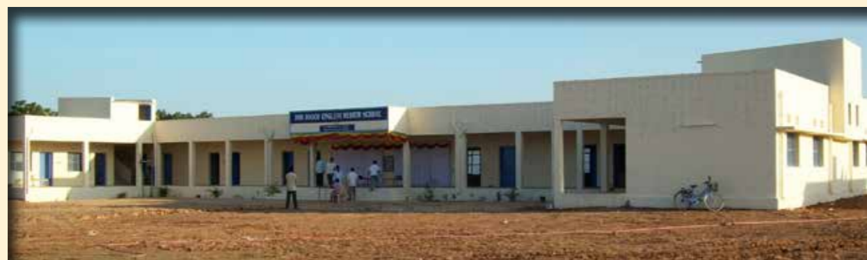
2009. CHEBROLU. Nieuw schoolgebouw met 10 klaslokalen. Omheiningmuur, toiletgebouw en woonruimte voor de leerkrachten.
