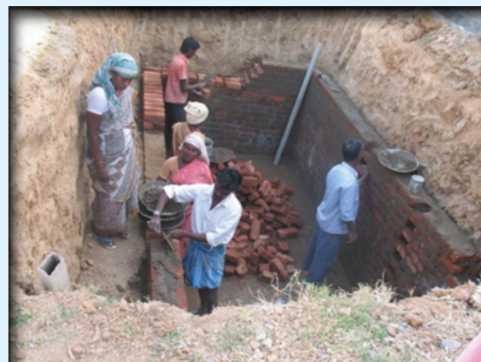
2011. JOLARPET. Verbeteren van de waterafvoer. Metselen van een afvoerput.
