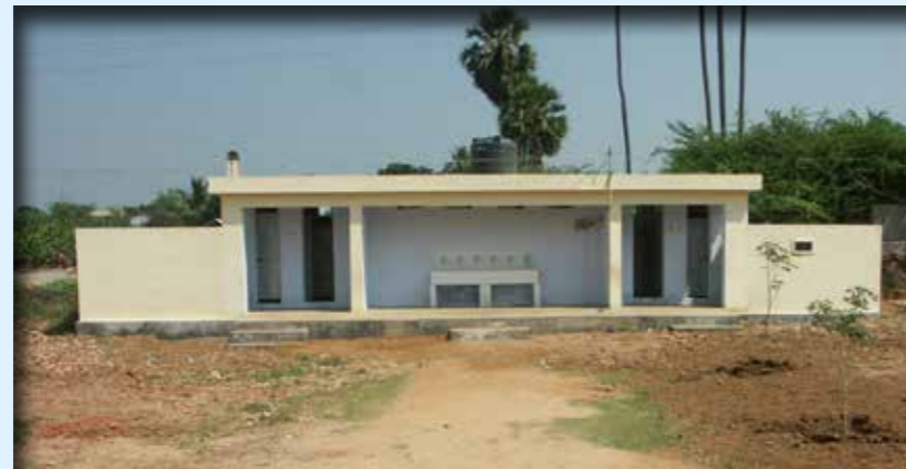
2004 SRIVAIKUNDAM. Nieuw toiletgebouw.
