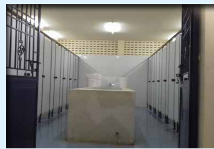
2017. PERAMBULUR. Toiletgebouw bij de boarding met 16 toiletten op de begane grond en 8 toiletten en 8 badcabines op de 1e verdieping (foto, toiletcabines)
