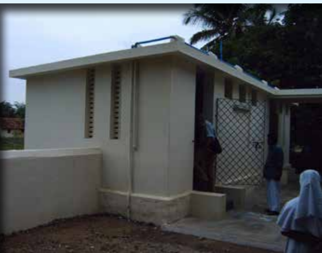
2006. PATHIAVARAM. Nieuw toiletgebouw
