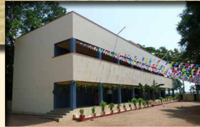
2012 P.T.PARRU. Nieuw schoolgebouw met 8 klaslokalen.
