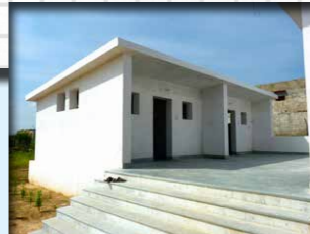
2011. GANGAPUR Nieuw toiletgebouw bij de kleuterschool.
