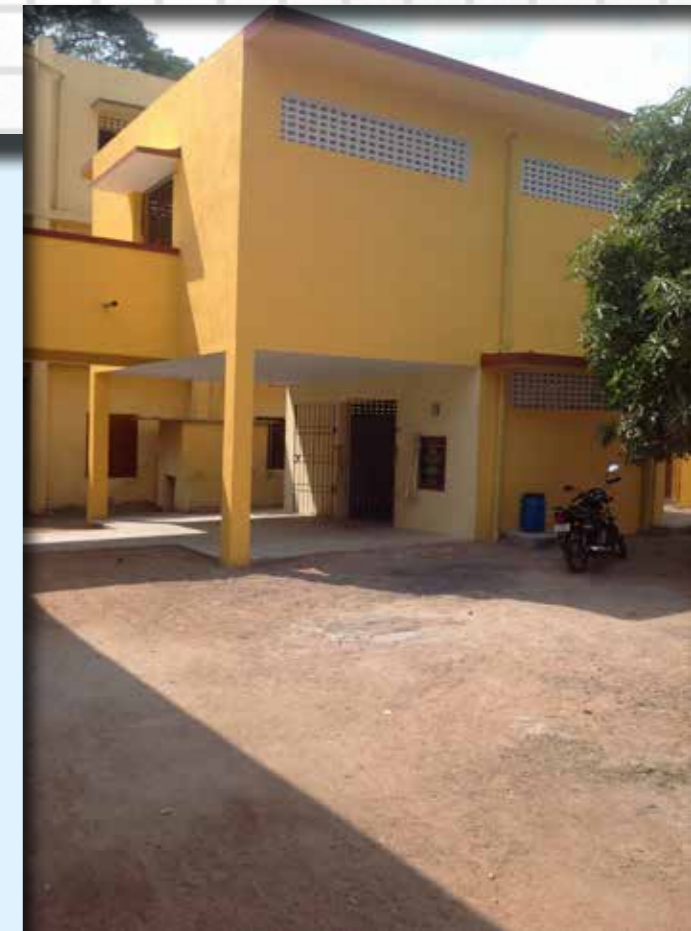
2015. VANDAVASI Nieuw toiletgebouw van 2 verdiepingen met in totaal 24 toiletten.
