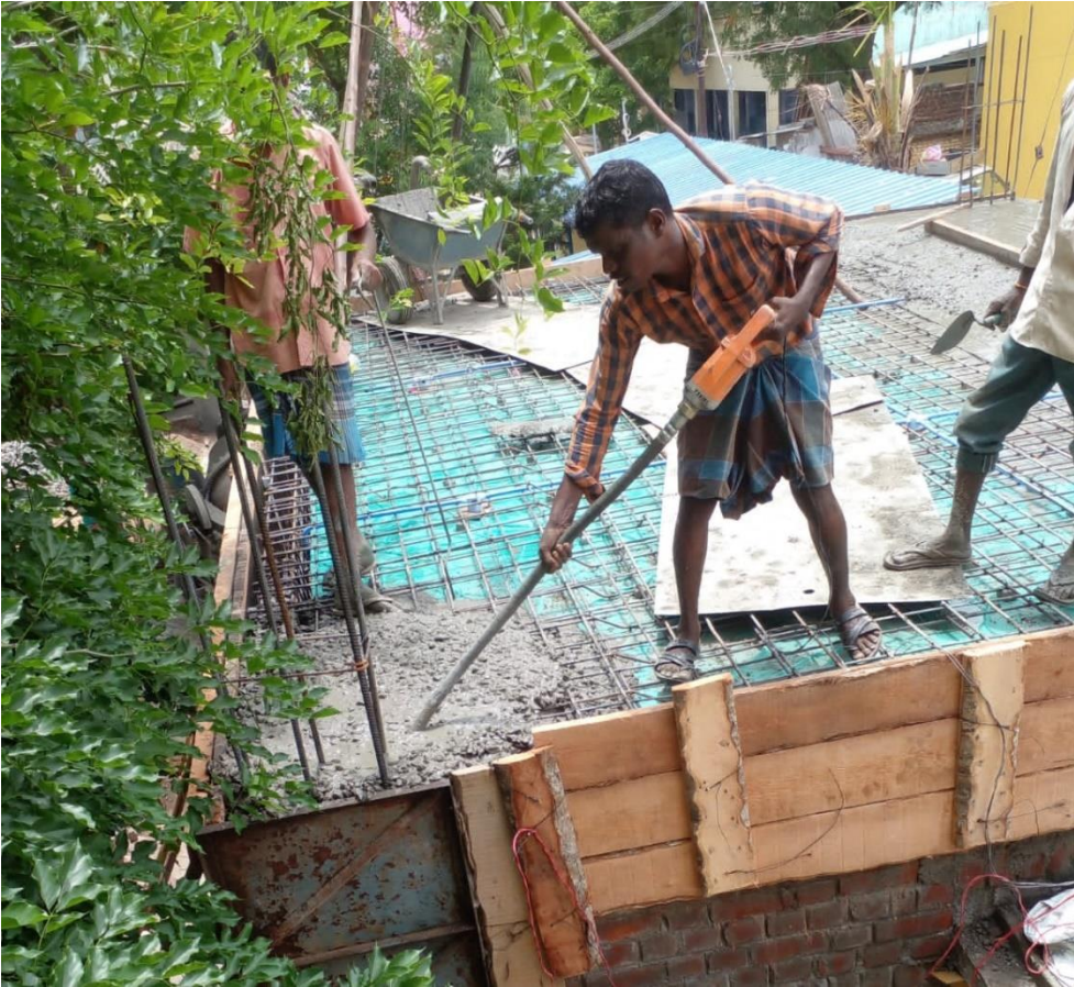
Storten en glad maken van het dak van het toiletgebouw
