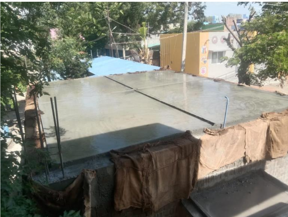
Storten en glad maken van het dak van het toiletgebouw
