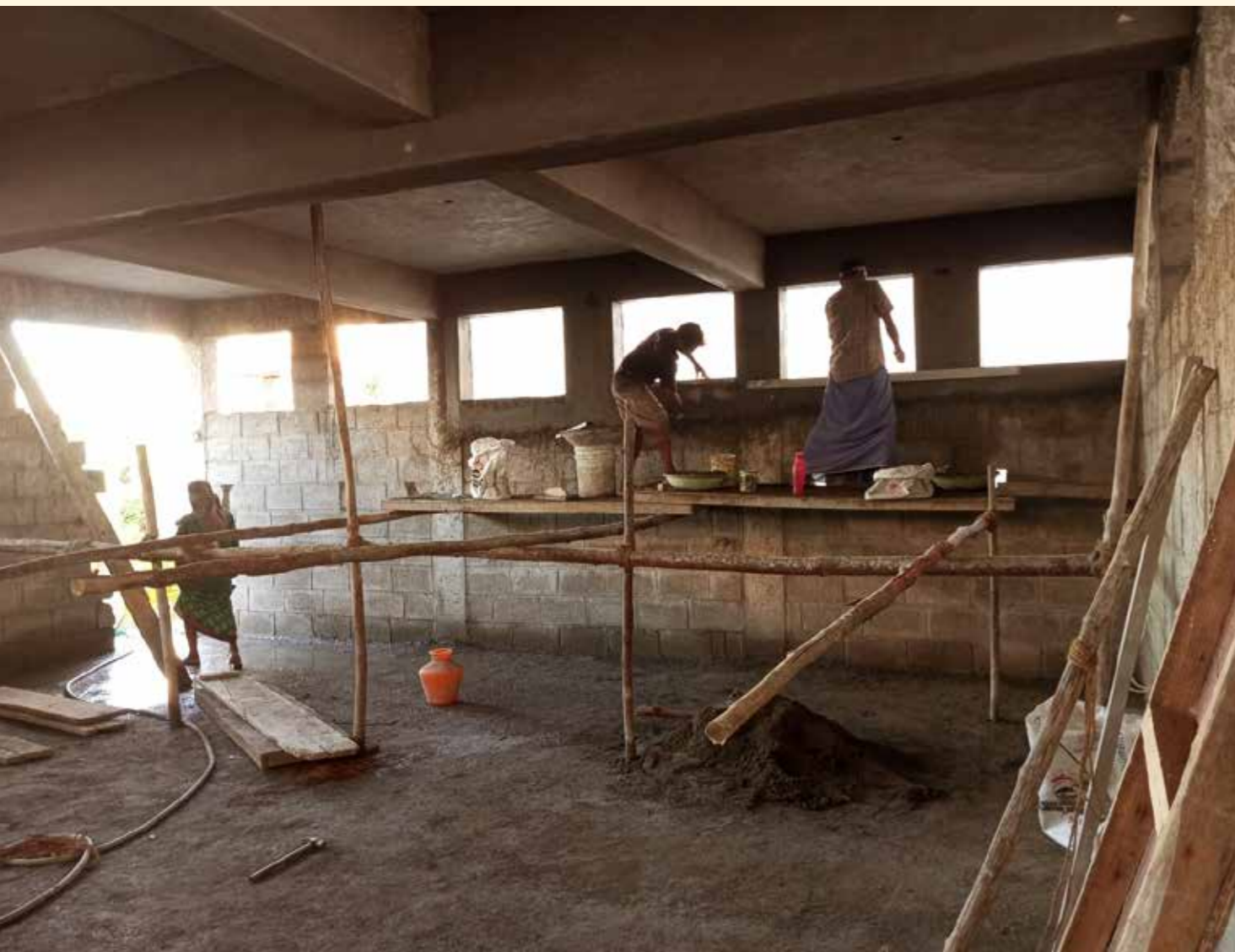
Het stucwerk wordt aangebracht
