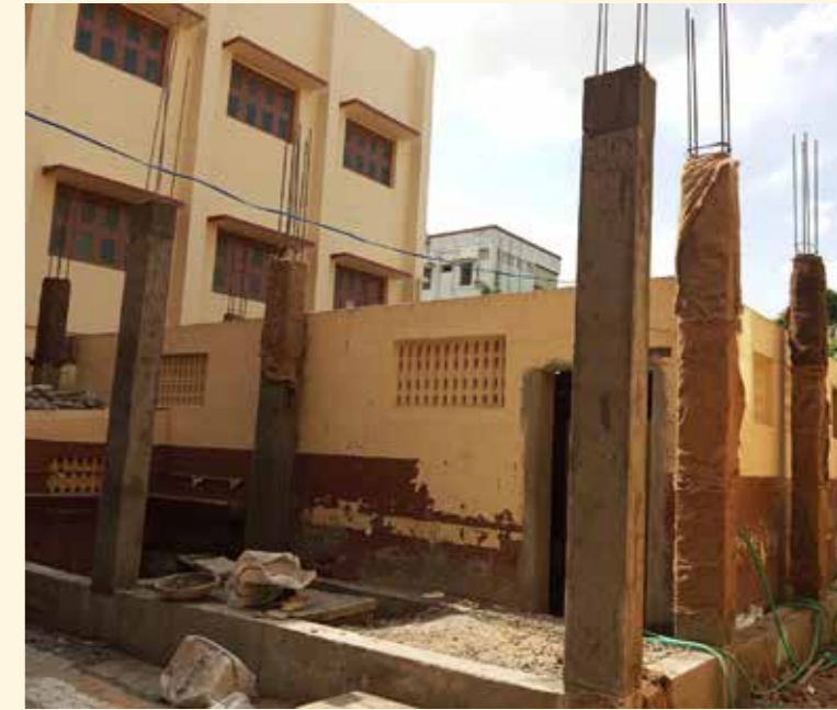
Er wordt over de oude toiletgroep heen gebouwd
