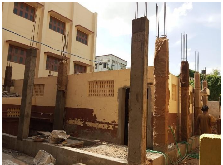
Nieuwe kolommen eerste verdieping rondom bestaande toiletgebouw
