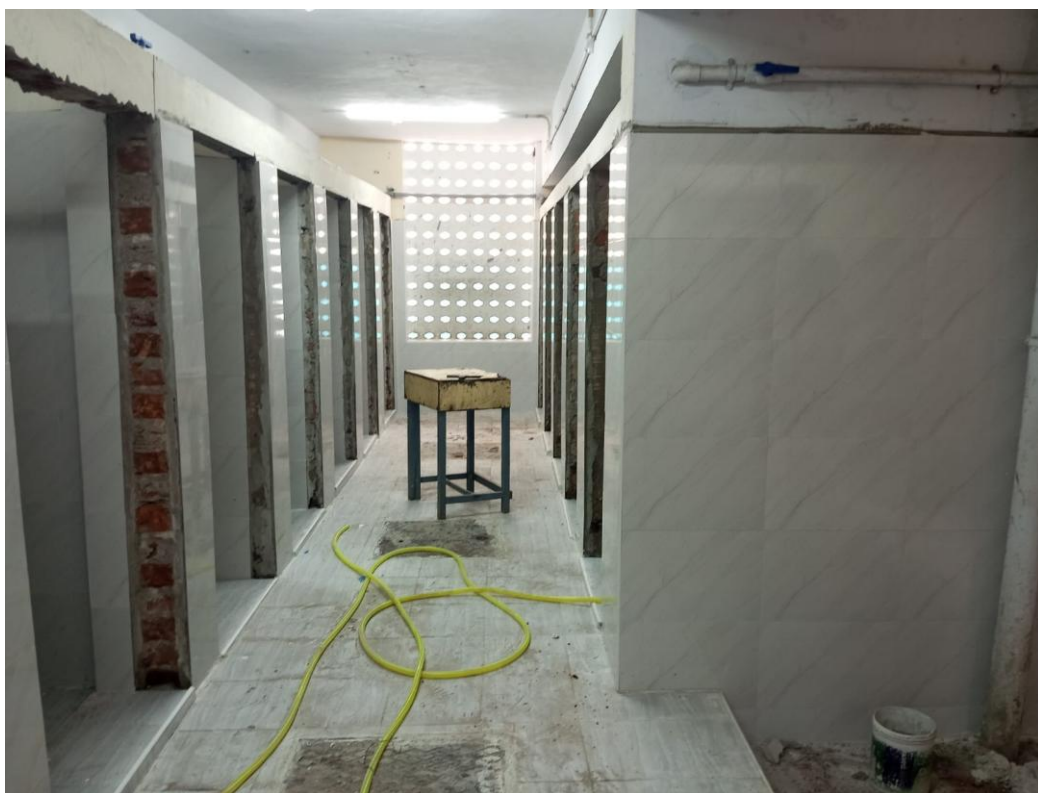
Werkzaamheden renovatie toiletten
