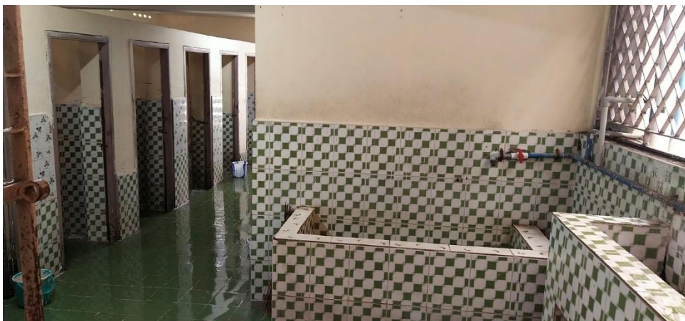
Situatie bestaande toiletten 2024
