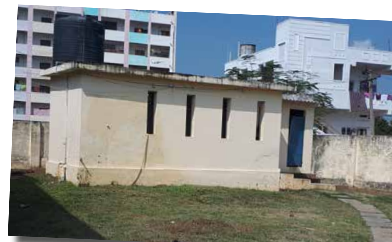
Het bestaande toiletblok voor meisjes en leraren
