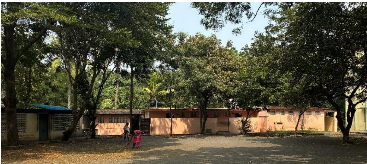
Thomas Mount. Bestaande toiletten verdeeld over drie gebouwtjes
