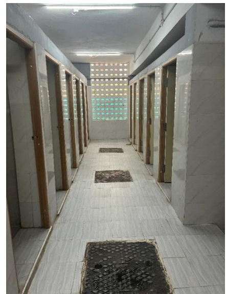
en het resultaat na renovatie
