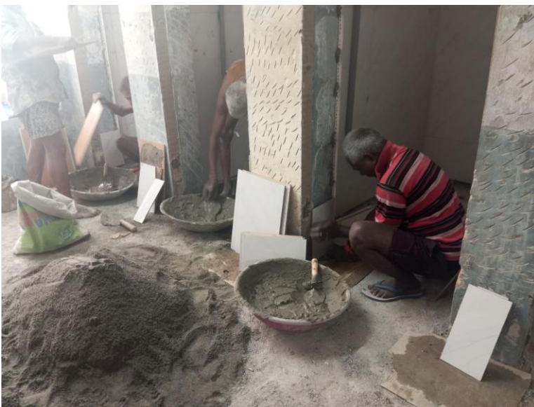
Renovatie werkzaamheden van de bestaande toiletten
