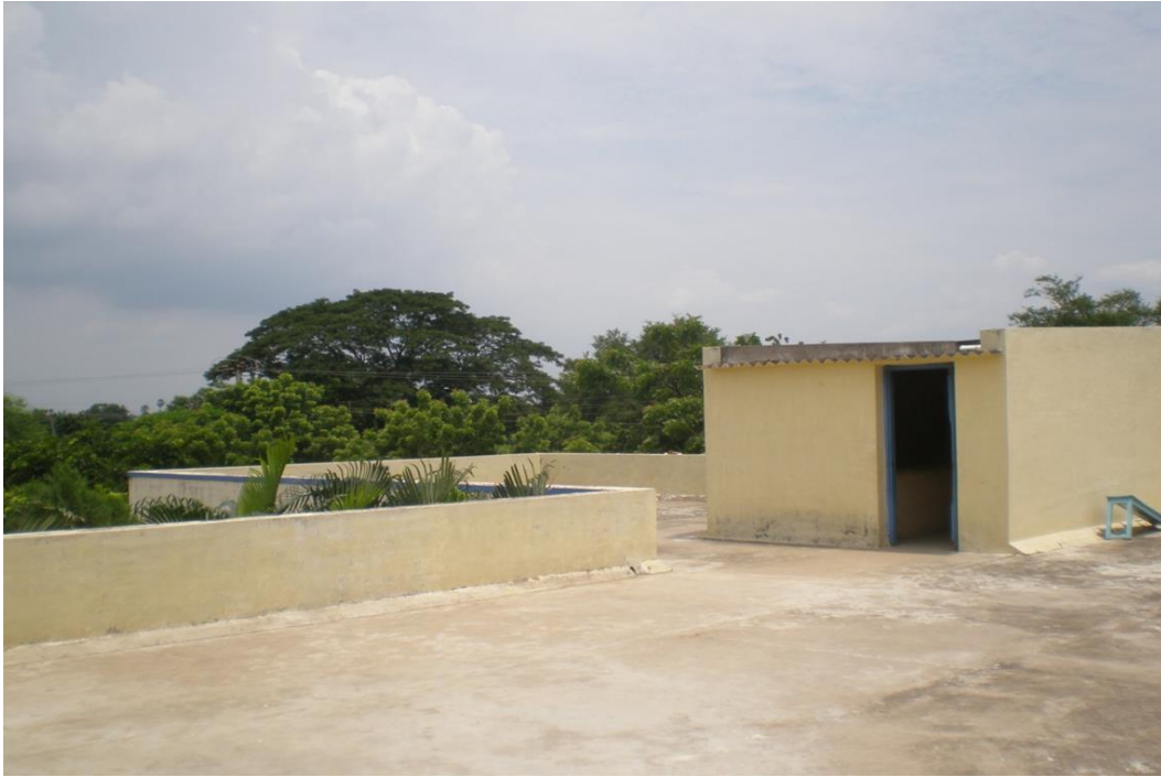
De beschermingsmuur op het dak.
