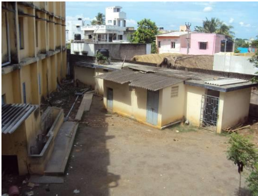
Voorkant huidige toiletgebouw
