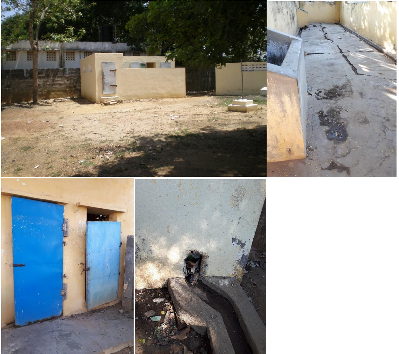
Sri Kalahasti: toiletgebouw en details, huidige situatie
