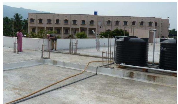
Jolarpet controle op het dak
