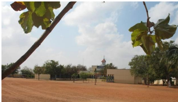
schoolgebouw, waarop aan de rechterkant een verdieping wordt gebouwd
