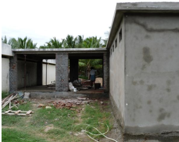
Toiletgebouw nog onvoltooid.
