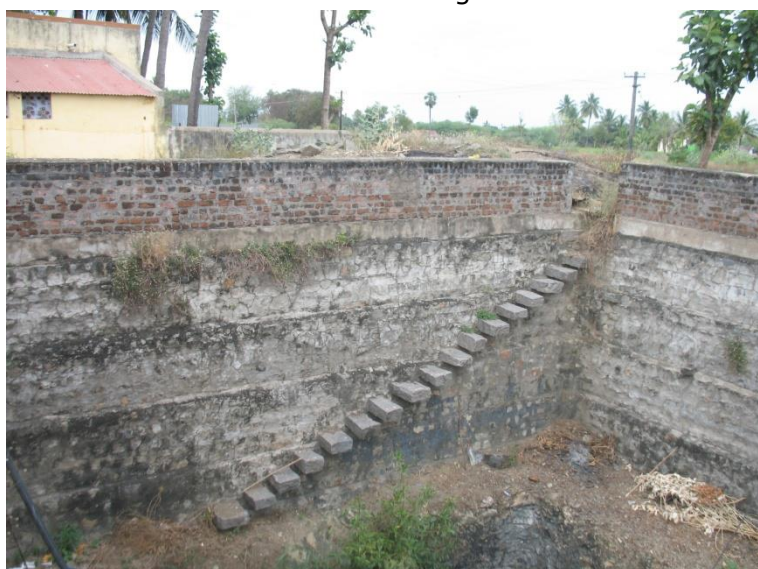
Waterput van 10 x 11 m, waarover ter beveiliging een afdekking zal worden aangebracht
