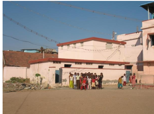
Meisjes voor het toiletgebouw, links de deur naar de gastentoiletten
