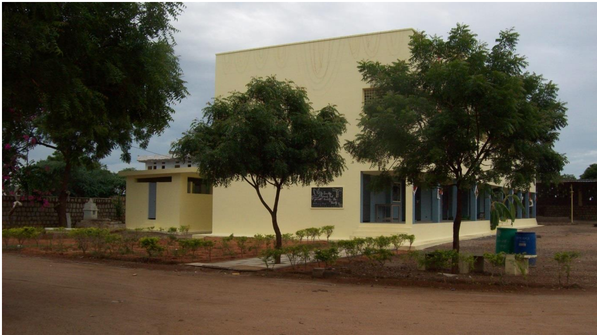
Het nieuwe schoolgebouw in Damaracherla
