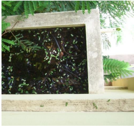
Water blijft staan...
