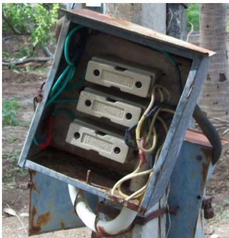
Gevaarlijke elektrische installaties
