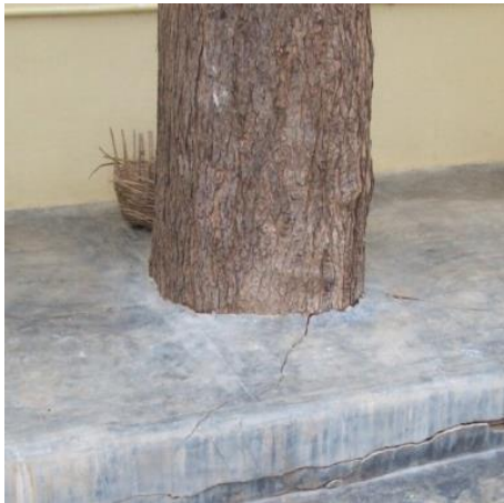
Betonstorten rond een boom...
