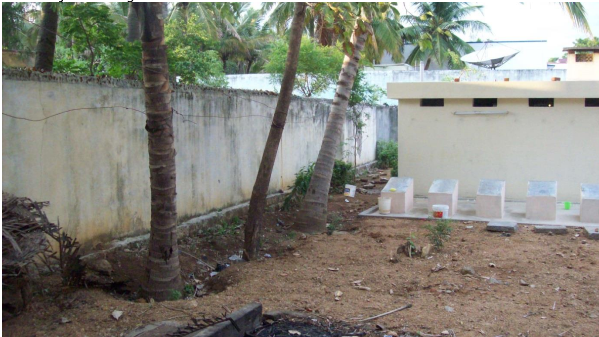
De bouwplaats voor het toiletgebouwtje in Jolarpet
