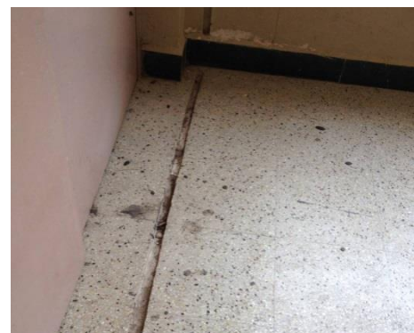
Verkeerde toepassing dilatatie (scheef en verspringend)
