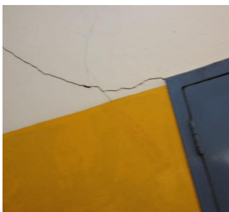
Scheurvorming in de hoeken
