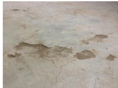
Scheurvorming in "waterdichte" laag
