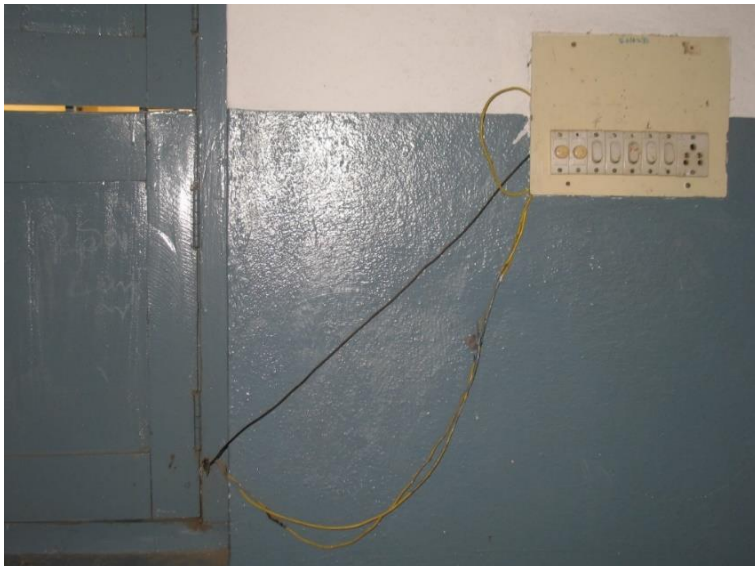
Foto 3924 Damaracherla: loshangende electra draden
