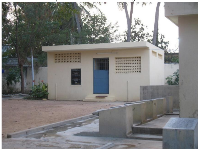
Foto 3934 Jolarpet: het nieuwe toiletgebouw
