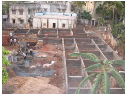
Bouw verpleeghuis bejaarde zusters
