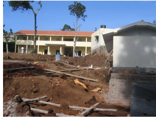
foto: school in Pannaikadu, met rechts het toiletgebouw en wat hoger rechts het oude schoolgebouw, dat gerenoveerd is. Ook is het talud te zien tussen de twee niveaus van de speelplaats.
