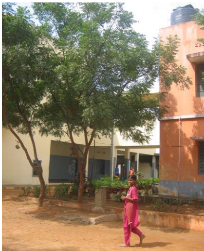
foto Kamalapuram: links het nieuwe en rechts het bestaande gebouw
