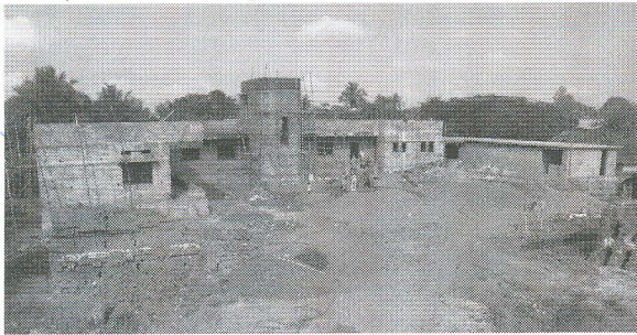
Het project Maiyanur is in aanbouw en vordert goed
