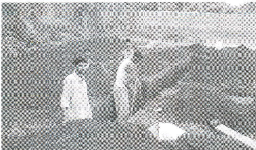
Met grote precisie doen vakmensen het graafwerk voor de fundering in Vegiwada.
