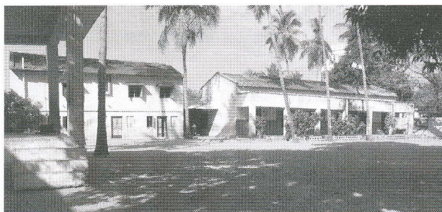
Walajabad. Het gebouw aan de rechterkant krijgt een nieuwe verdieping.
