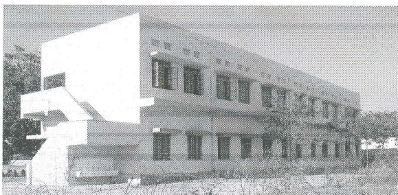
De nieuwe verdieping in Damaracherla ligt te blinken in de zon
