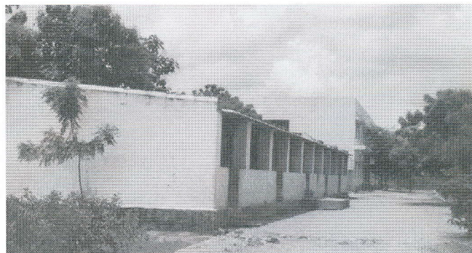
Dit gebouwtje wordt aangepast tot vier volwaardige schoollokalen
