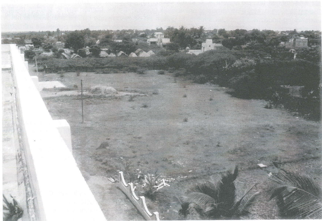
Vandavasi : bouwterrein hostelgebouw.
