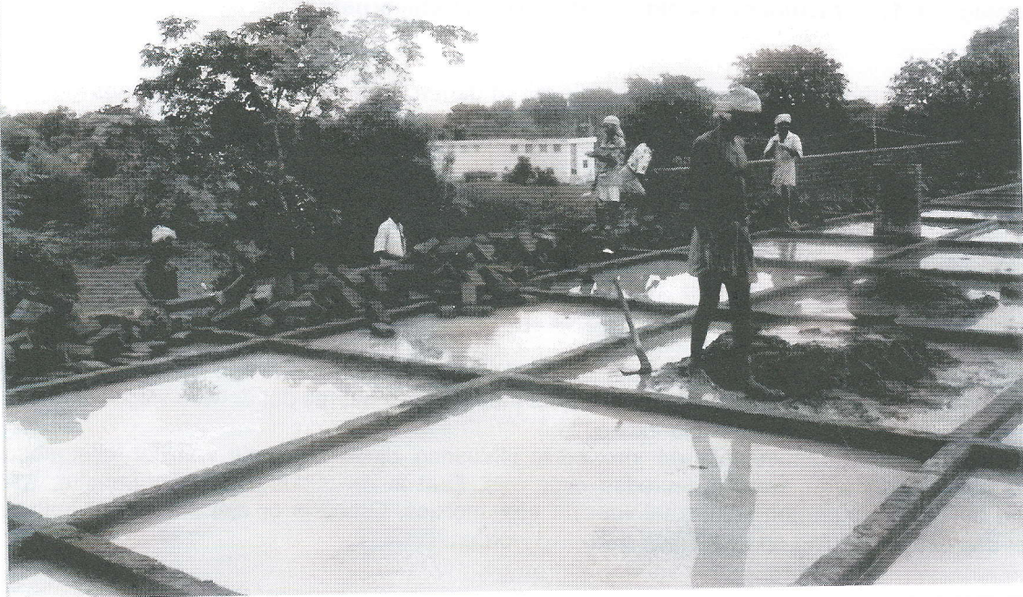
Okkur: schoolgebouw. Dak en borstwering in aanbouw.
